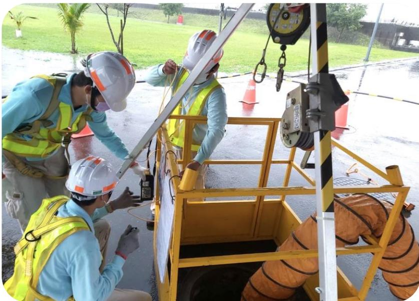
職安署表示，進入人孔、儲槽等通風不良的局限空間或缺氧作業場所，其內部空氣易因混雜高濃度硫化氫或因惰性氣體等洩漏而造成缺氧環境，工作者若未能正確辨識危害及採取必要之預防措施，易因中毒或缺氧釀成重大災害。希望藉由本次與地方政府共同辦理示範觀摩，演練安全作業程序，供相關事業單位遵循。局限空間或缺氧作業只要能作業全程通風換氣，並以氣體監測器持續測定空氣中有害物及氧氣濃度等措施，即能有效預防類似災害發生。事業單位除應加強危害預防措施外，更應持續提升工作者危害認知。同時，職安署於官網也建立「局限空間作業專區」提供相關的影片、教材等供各界多加利用，共同提升職場安全衛生水準。
