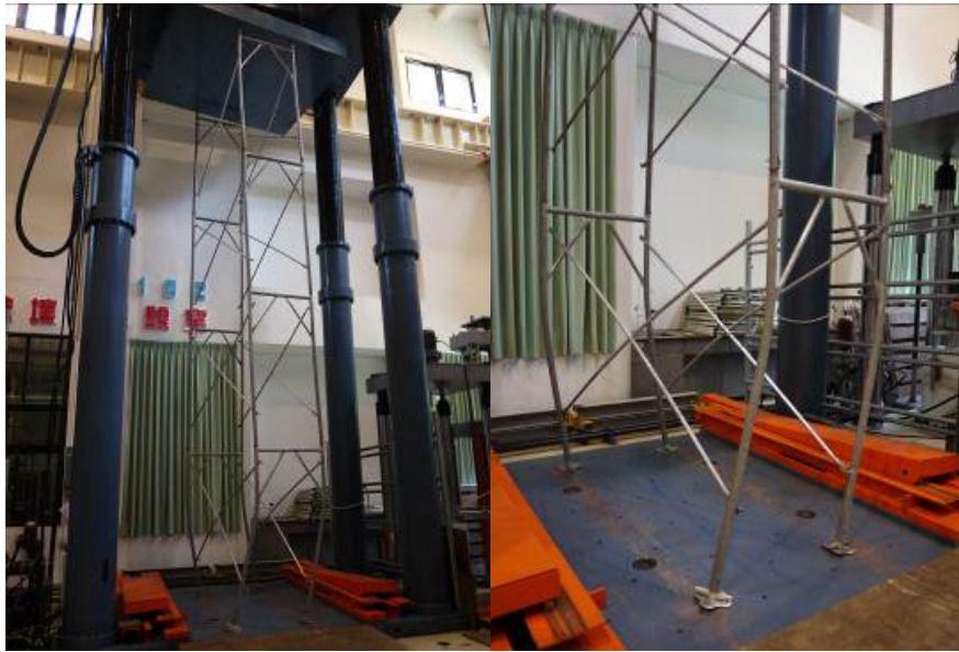
圖3 多層框式施工架承載力試驗及破壞情形
