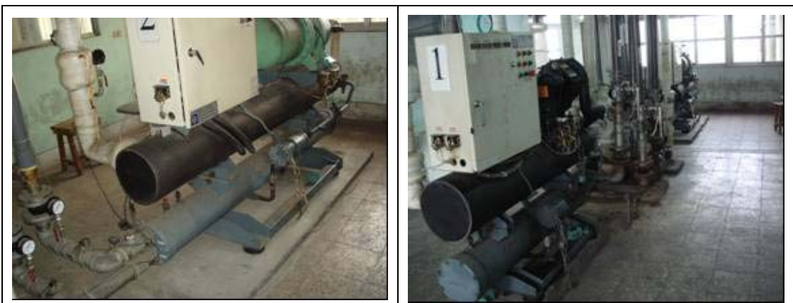
備註：具有相態變化(水蒸氣↔水)之冷凝器及蒸發器
